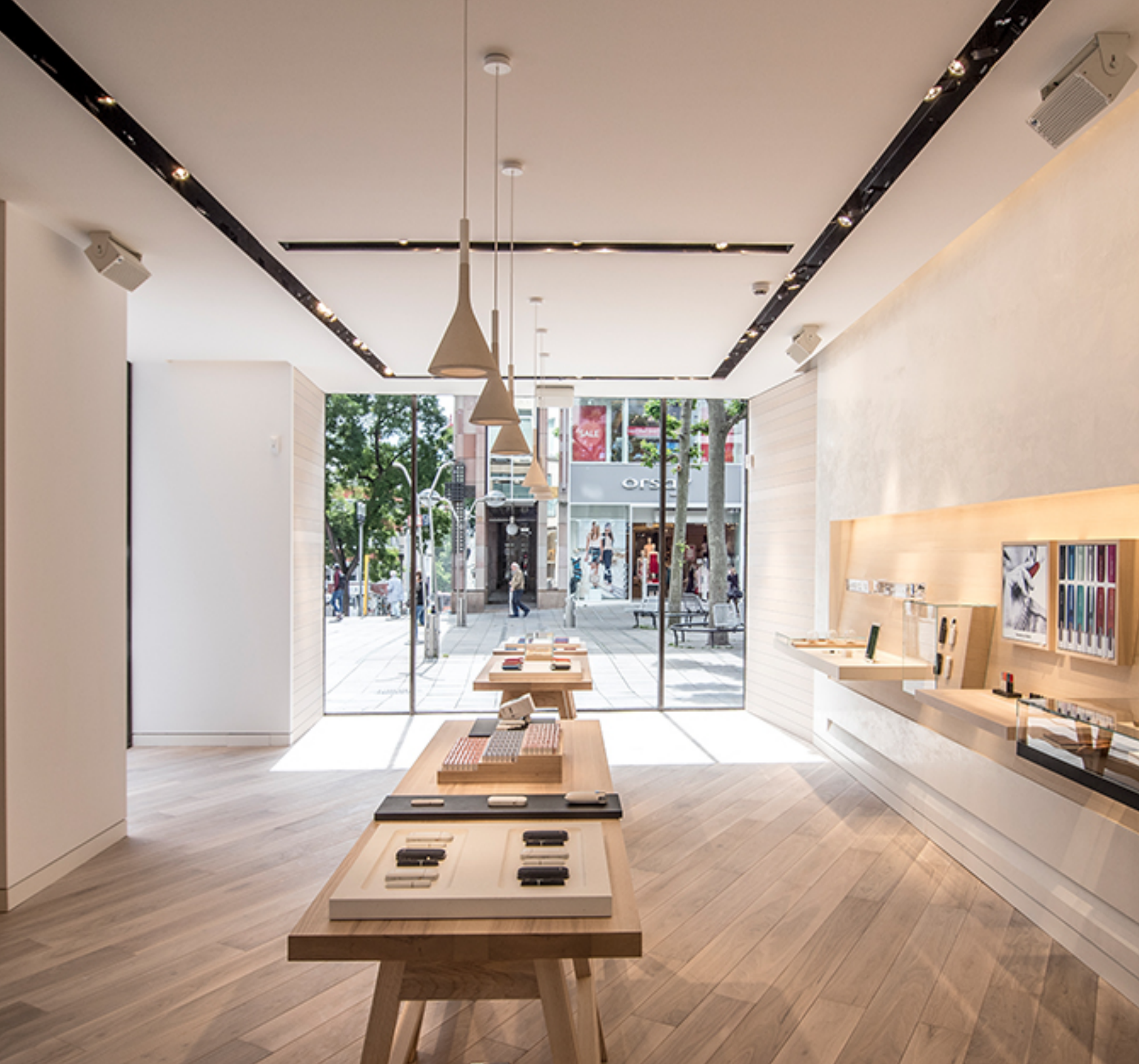
Illuminazione d'accento effetto dark-light con proiettori orientabili all'interno di canale e illuminazione ambiente con wall-washer perimetrali nei negozi IQOS
