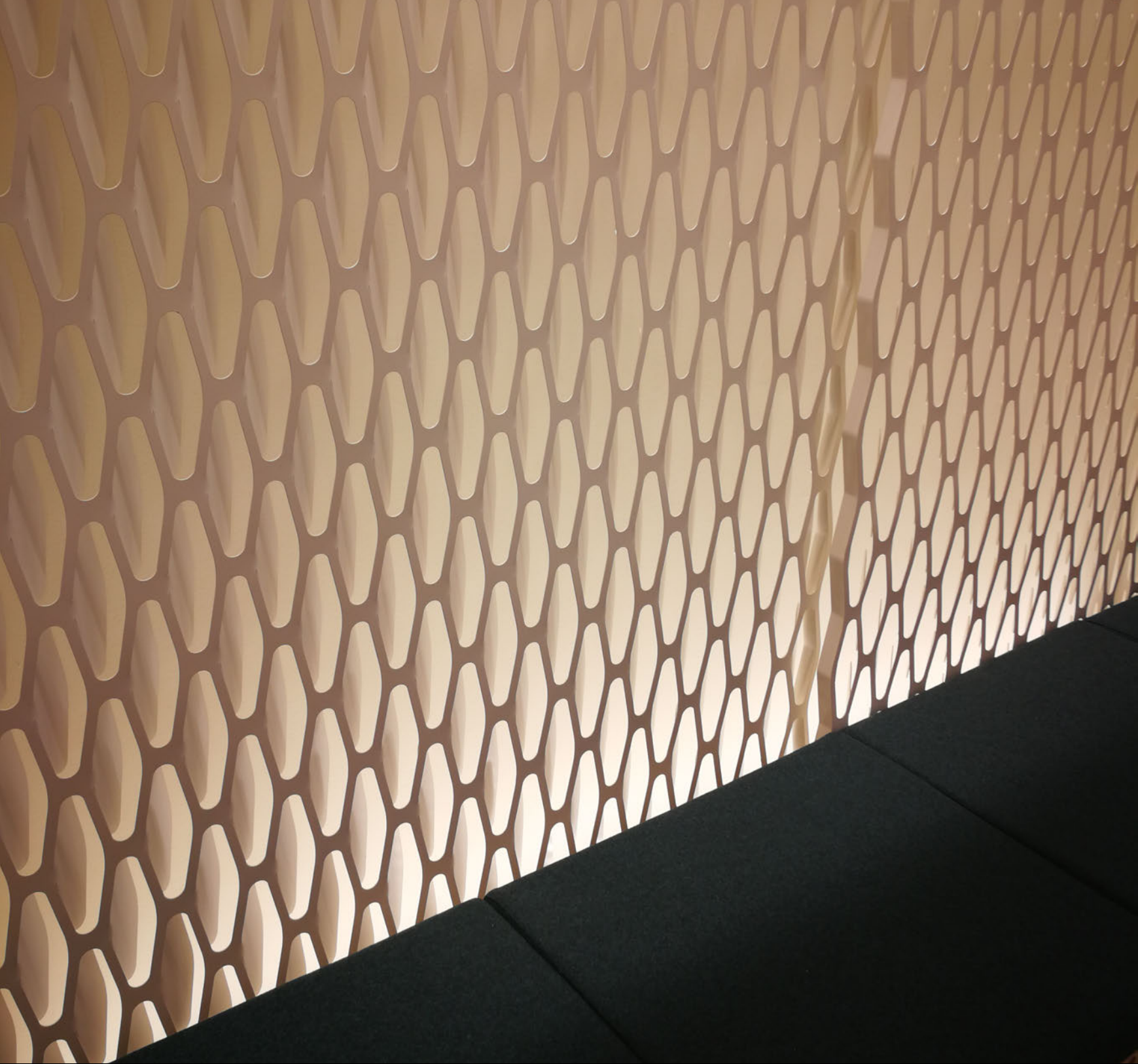
Illuminazione wall-washer incassata a pavimento per animare la texture dei metal screen perimetrali del negozio
