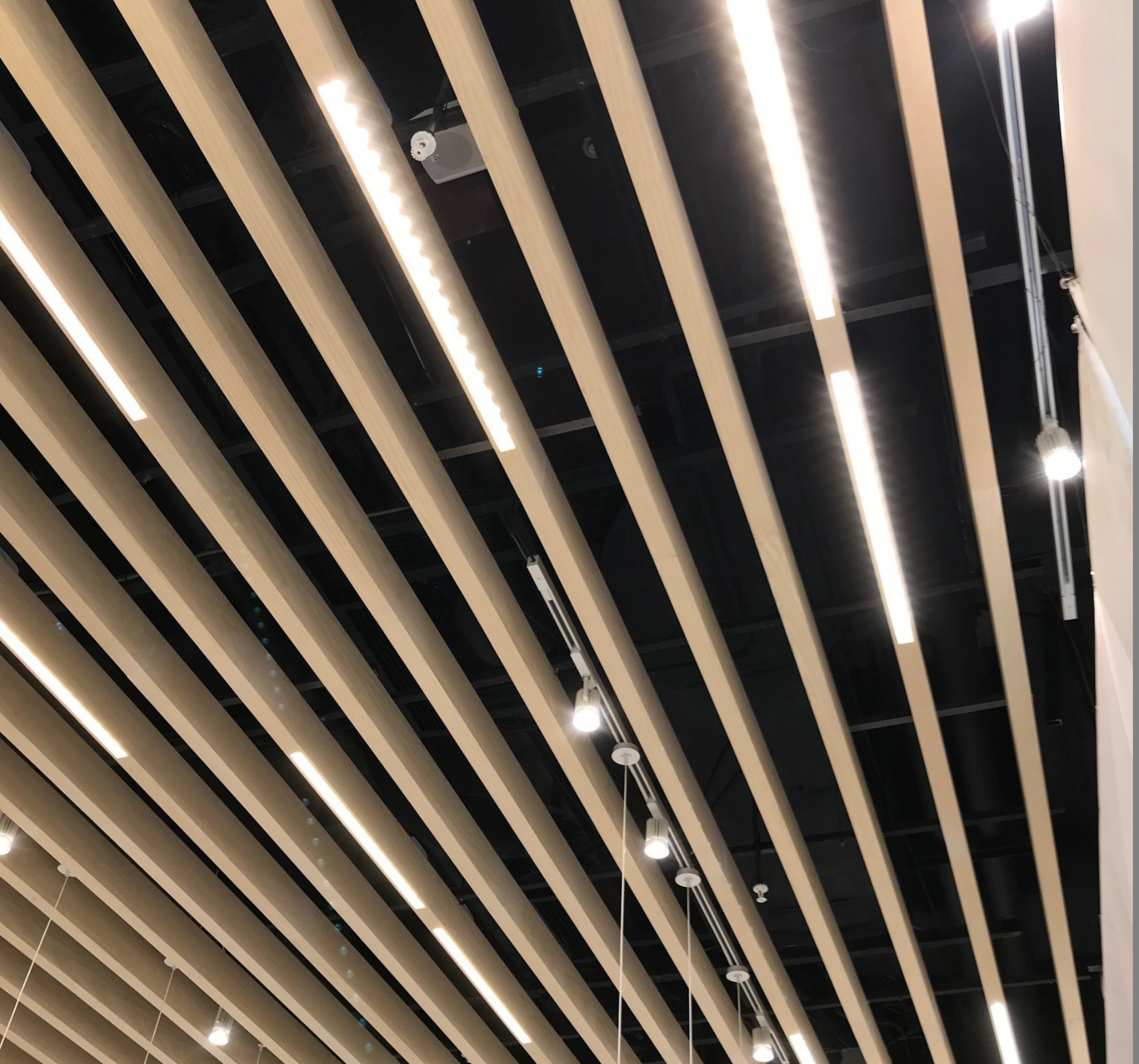
LIGHT BLADE da incasso realizzati ad hoc trasformano i travetti di legno in elementi luminosi nei comer IQOS
