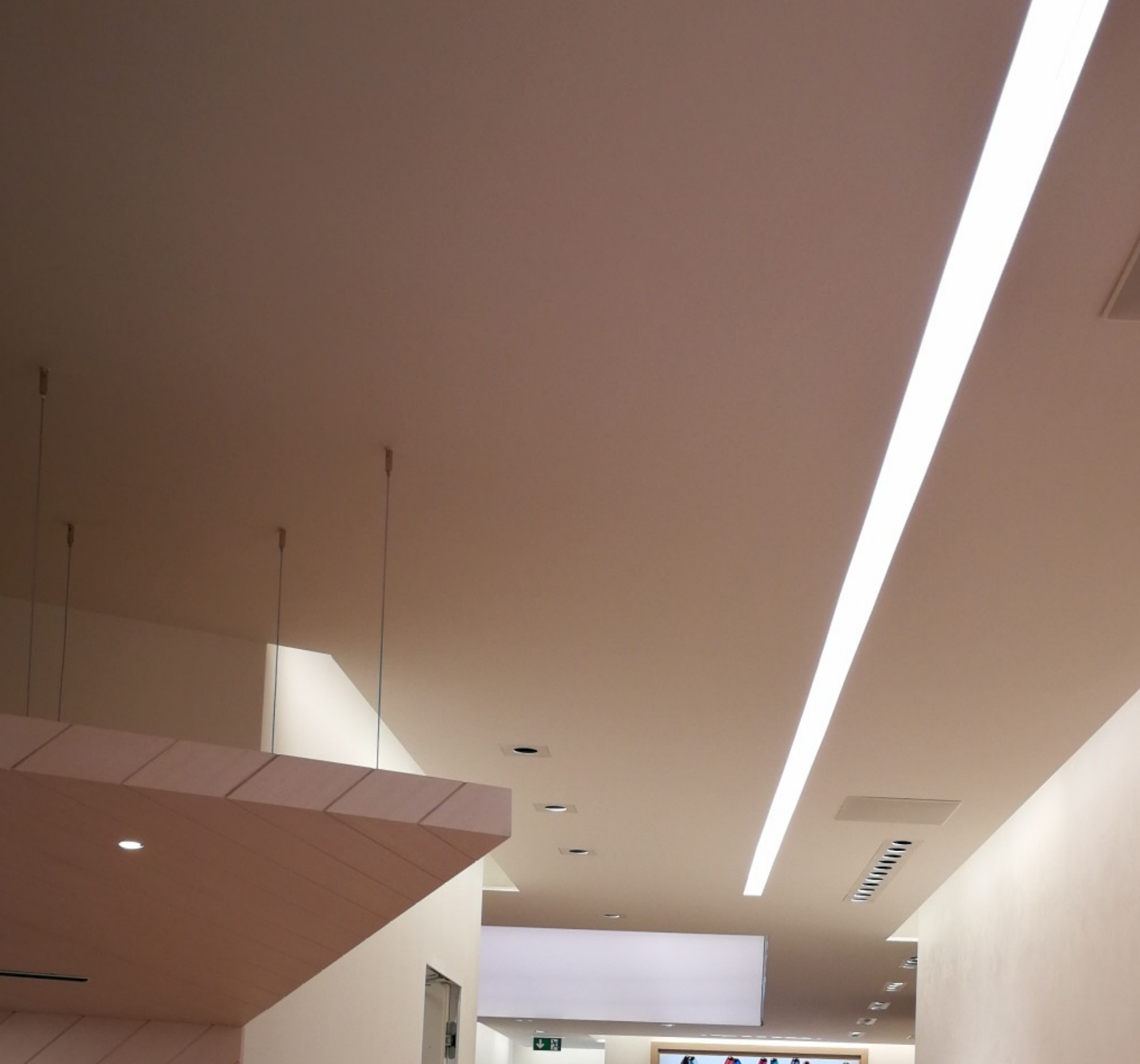
Proiettori da incasso, profili wall-washer e tagli di luce studiati e coordinati nel Concept luminoso dei negozi IQOS
